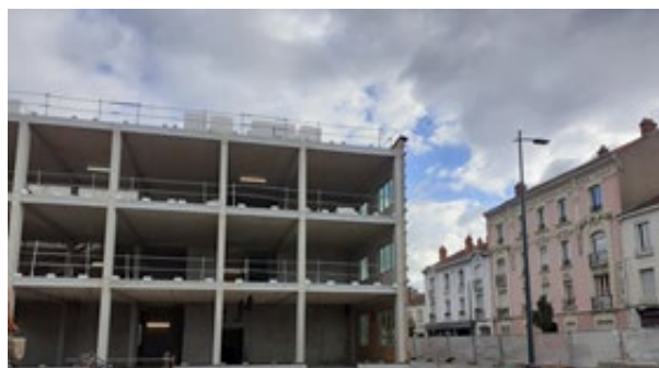
Chantier du bâtiment - Campus Pierre Mendès France à Roanne
